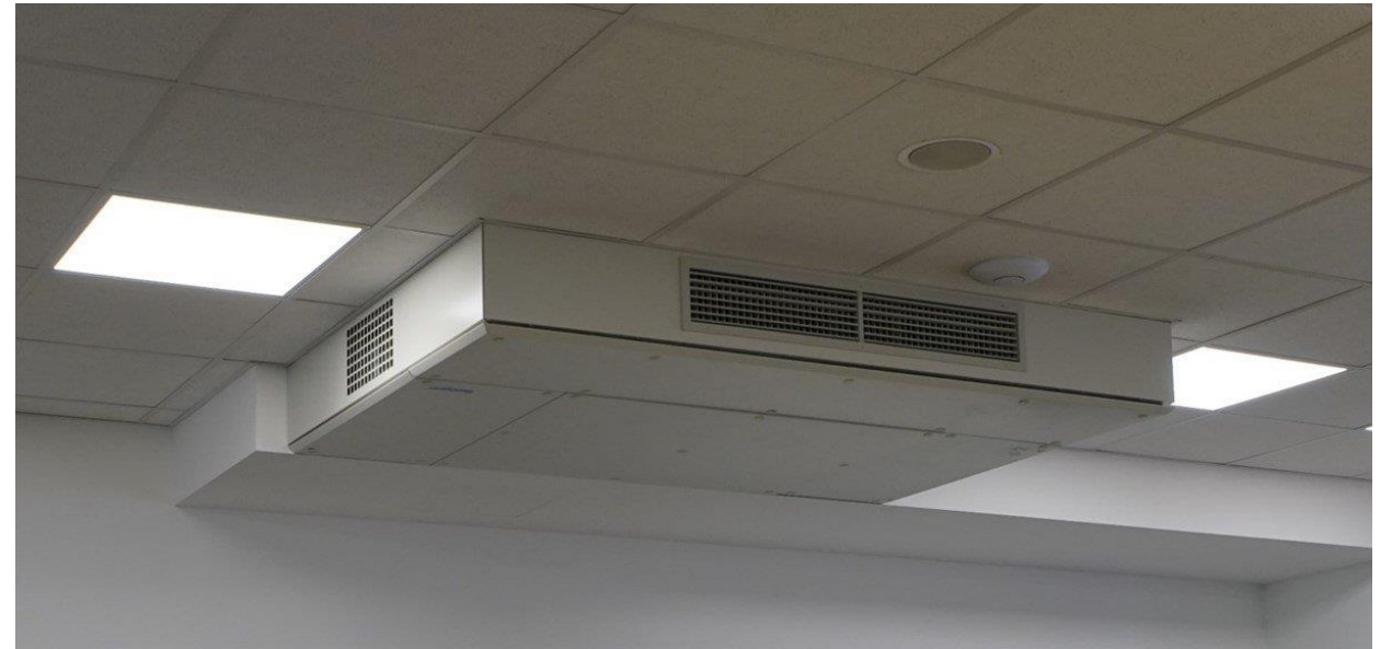
Variante RLT- Gerät (Deckengerät)
